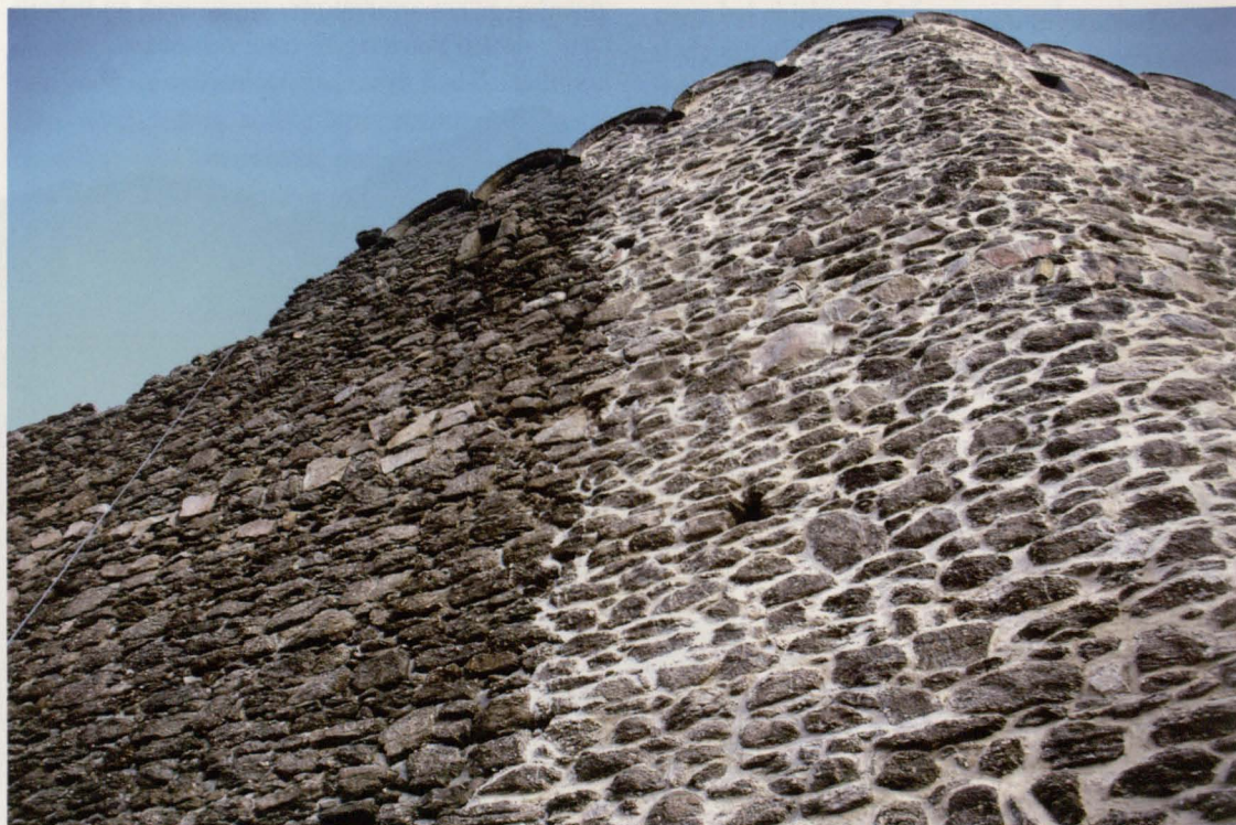
Zewnętrzna strona muru zachodniego – jaśniejsza część po remoncie
