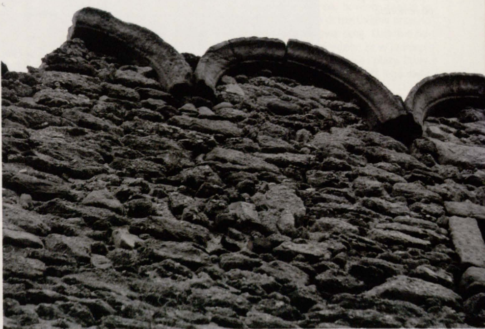
Stan murów przed remontem
