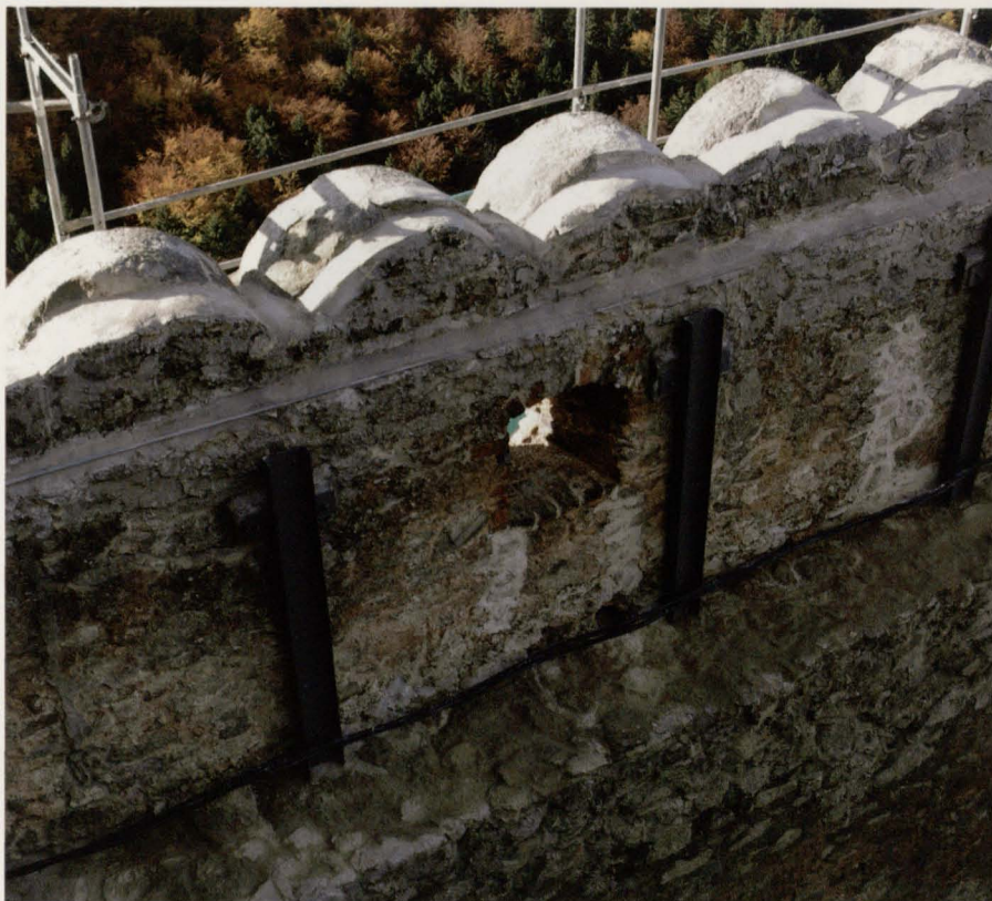
Wewnętrzna strona muru zachodniego ze stalowymi wzmocnieniami
