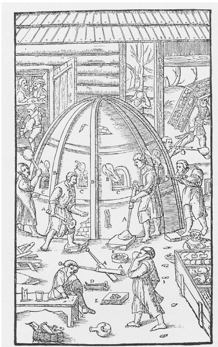
In einer alten Glashütte Aus Agricola: „ De re metallica (1556)
