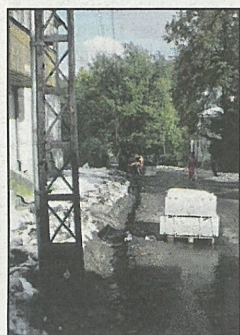
Przebudowa ul. Górskiej w Świeradowie Zdroju.
