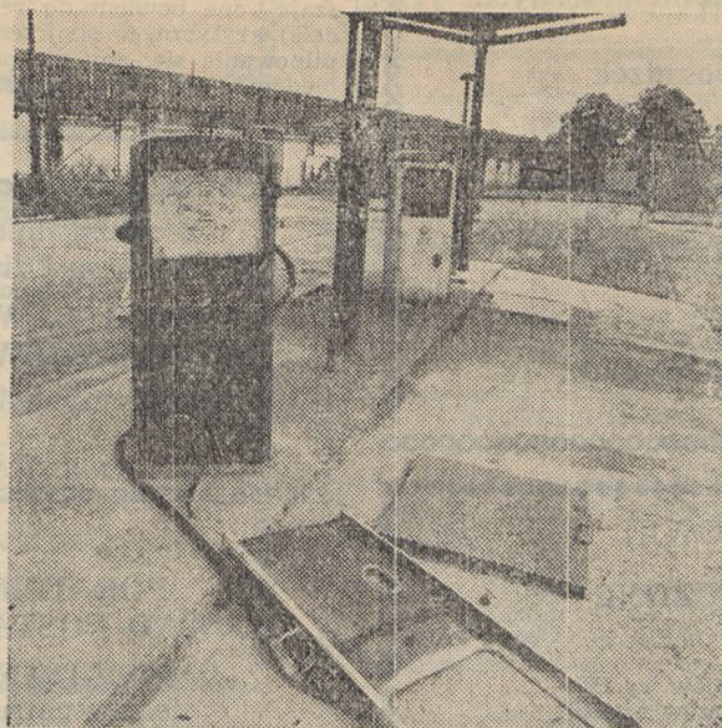
5. ...na stacji benzynowej — szkielety dystrybutorów i innych urządzeń...
