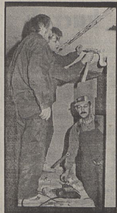
Na zdjęciu: ekipa monterów przy instalacji kotłowni.
