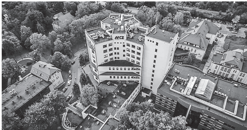
Budynek Miedziowego Centrum Zdrowia w Legnicy, fot. MCZ
