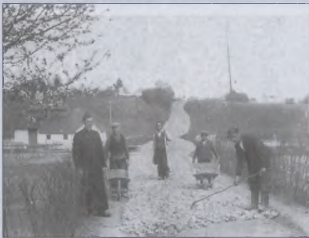
Praca przy budowie szosy z parafianami
