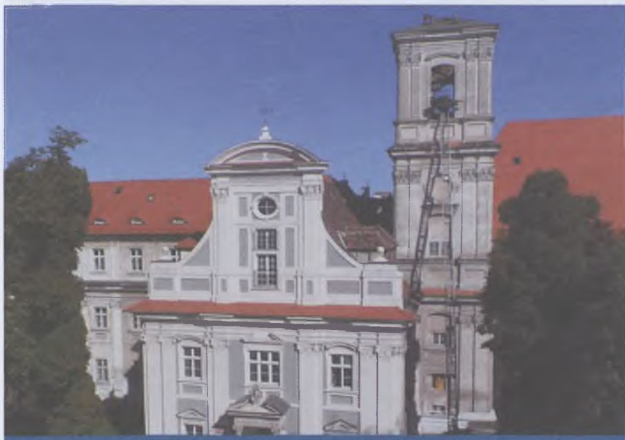
Remont wieży klasztornej
