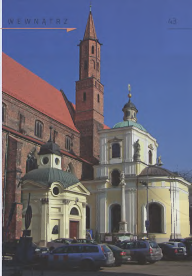
3. Katedra greckokatolicka św. Wincentego i św. Jakuba, widok od południowego zachodu
