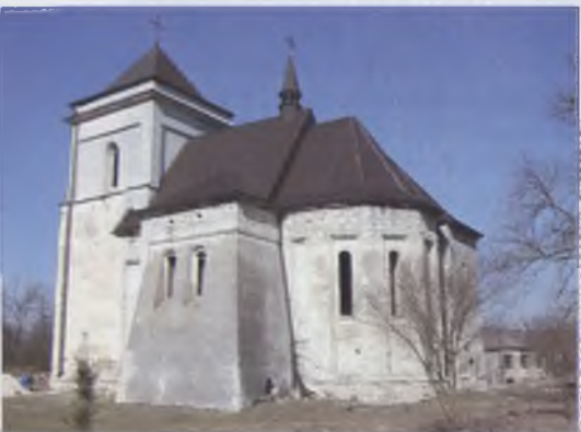
Kościół z nowym dachem
