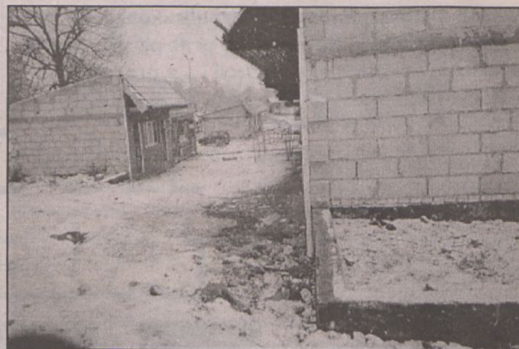
Trwa modernizacja Podzamcza
