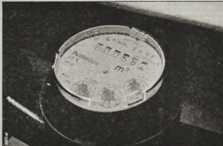
To niewielkie urządzenie to wodomierz. Jeśli w mieszkaniu jest wodomierz, wtedy płacimy tylko za taką ilość wody, jaką zużyliśmy. Jeśli wodomierza nie mamy, płacimy za wspólne zużycie wody – i oznacza to o wiele większe koszty
