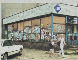
Budynek wygląda strasznie. Mamy nadzieję, że miejscy urzędnicy w końcu zgodzą się na rozbiórkę!
