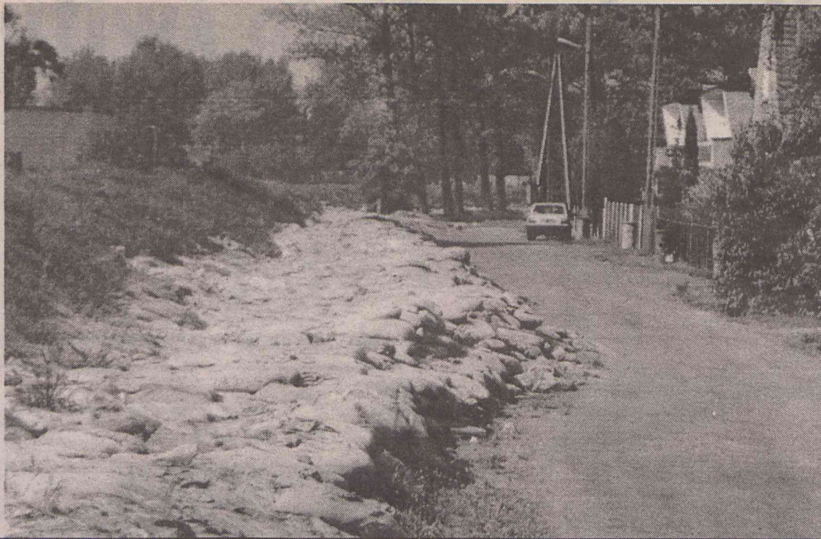
Worki na ulicy Bażantowej czekają do remontu wału
