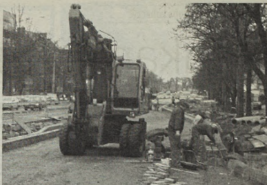
Ulica Curie-Skłodowskiej jest teraz wielkim placem budowy.
