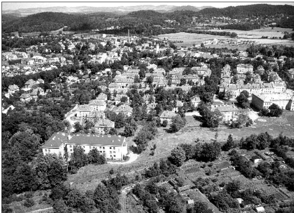
Kowary – osiedle górnicze zbudowane w latach 1949-1952, fot. Krzysztof Sawicki
