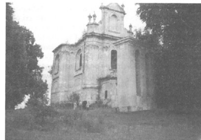
Kościół w Hodowicy k. Lwowa – zniszczony, wygląd obecny
