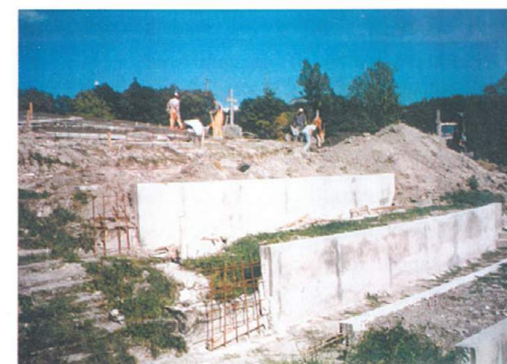
Budowa murów oporowych kwatery na stoku
