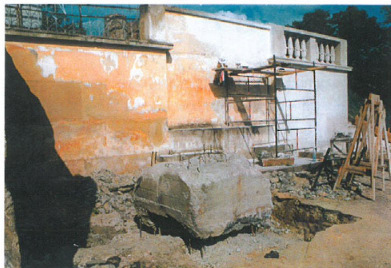
Odbudowa kamiennej balustrady i schodów
