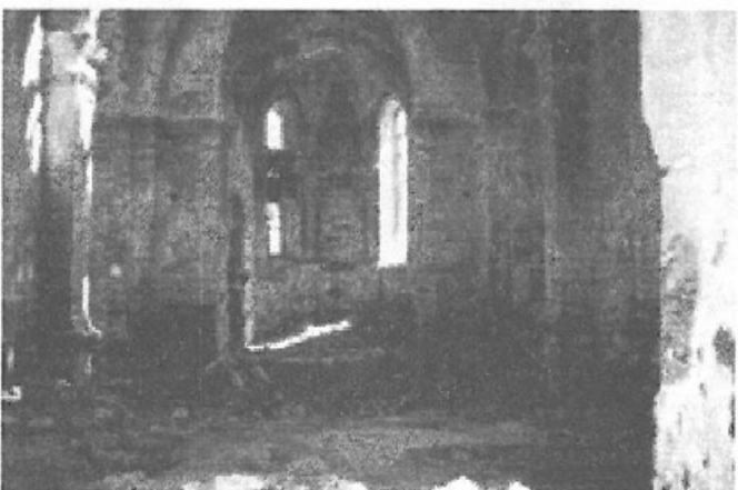
Obecny stan wnętrza kościoła na zamku Sieniawskich w Brzeżanach
