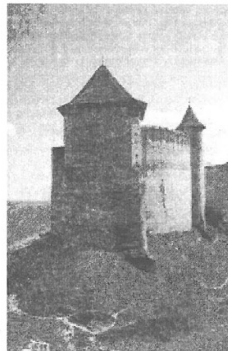
Północna część zamku. Widoczna Baszta Północna – donżon, czyli ogromna wieża refugialna.
