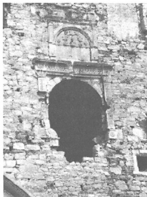
Portal wyjazdowy z herbem Abdank znajdujący się na wieży południowo-zachodniej
