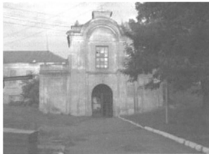
Stan obecny Bramy Wjazdowej zamku w Olyce
