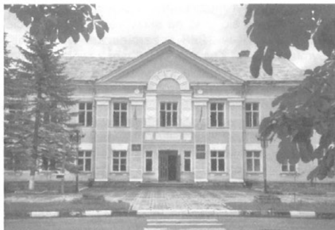
Żabie – budynek Urzędu Powiatowego, tzw. „Biały Dom”
