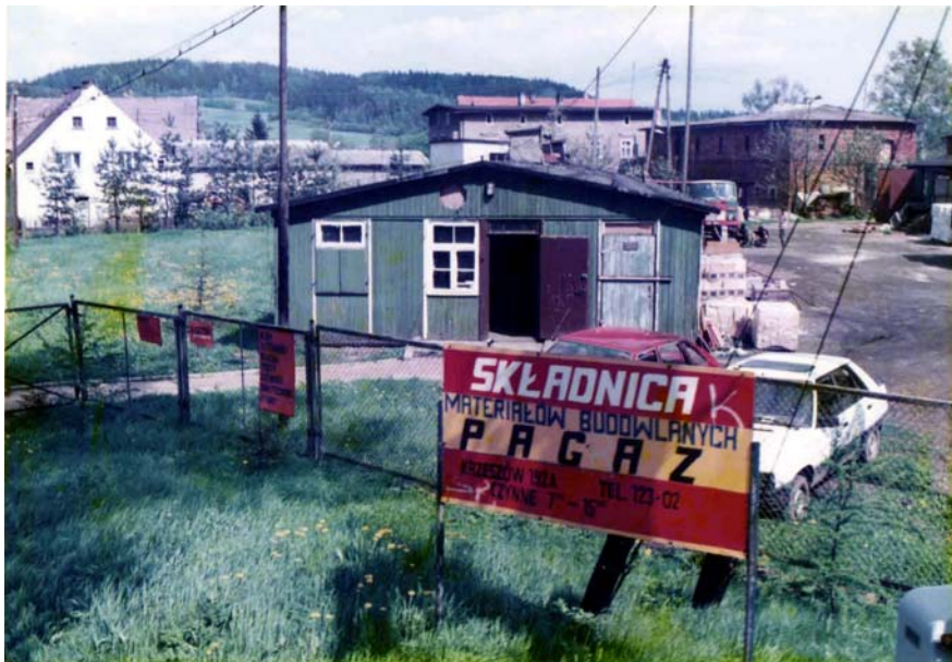
Ilustracja 46: Fotografia przedstawiająca wejście do składnicy materiałów budowlanych „Pagaz”, zlokalizowane w zachodniej ścianie szczytowej baraku „A”. Źródło fotografii: zdjęcie z końca XX wieku ze zbiorów Bogdana Pazgana.
