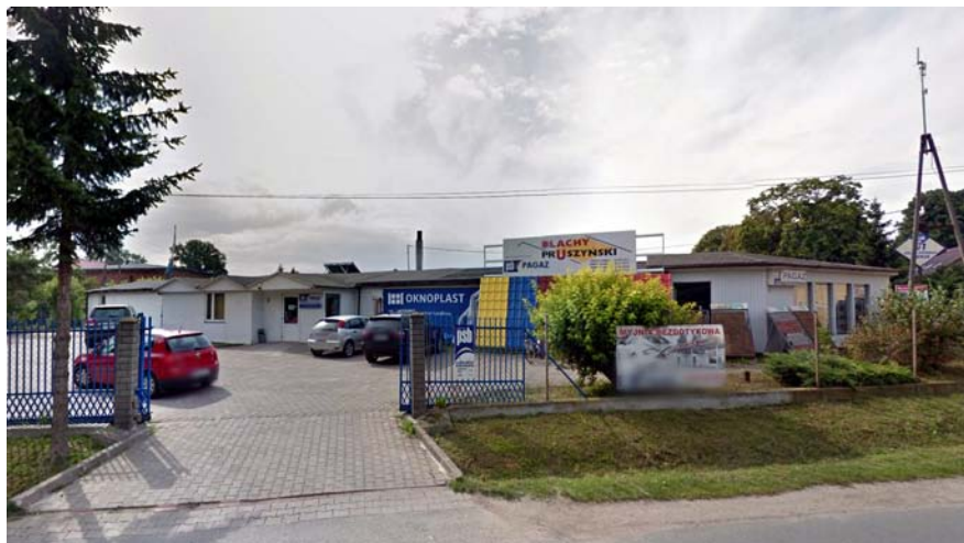
Ilustracja 55: Widok od strony ulicy Świętej Jadwigi Śląskiej: po lewej stronie barak „A”, tuż przesiłnięty przybudówką z wejściem do hurtowni, po prawej stronie dobudowany po wojnie łącznik narożny pomiędzy barakami „A” i „B”. Źródło fotografii: zdjęcie Google Street View z lipca 2012 roku.
