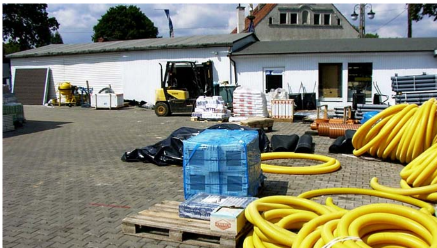
Ilustracja 52: Zdjęcie wykonane z tego samego miejsca co fotografia z ilustracji 51, lecz w przeciwnym kierunku. Za placem poprzeczne ustawiony budynek, którego lewa część jest dawnym barakiem obozowym „B”, natomiast prawa strona stanowi fragment dobudowanego w latach powojennych łącznika pomiędzy barakami „B” i „A”. Za zabudowaniami widać fragment ściany szczytowej budynku przedwojennej gospody „ Gasthof zum deutschen Reich ”. Fotografia: Marian Gabrowski, lipiec 2003 roku.
