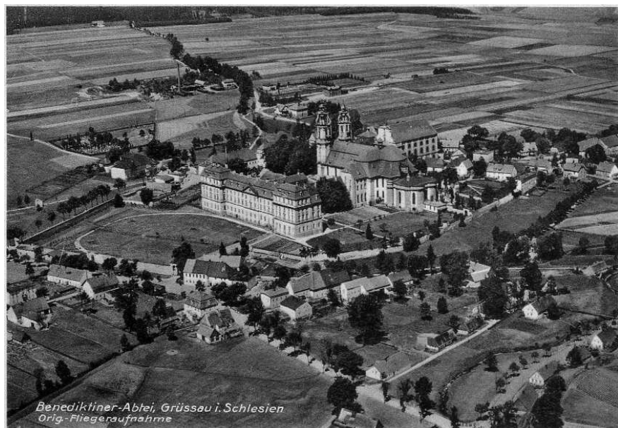
Ilustracja 39: Zdjęcie lotnicze krzeszowskiego klasztoru. Po lewej stronie widoczna piekarnia i budynek koło bramy klasztornej. Źródło: pocztówka sprzed 1945 roku.
