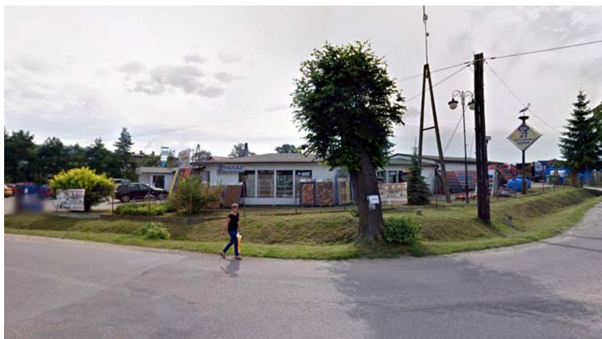
Ilustracja 56: Widok ze skrzyżowania ulic Świętej Jadwigi Śląskiej oraz Michała Willmanna: w środku kadru łącznik narożny pomiędzy barakami „A” i „B”, po prawej stronie barak „B”. Źródło fotografii: zdjęcie Google Street View z lipca 2012 roku.
