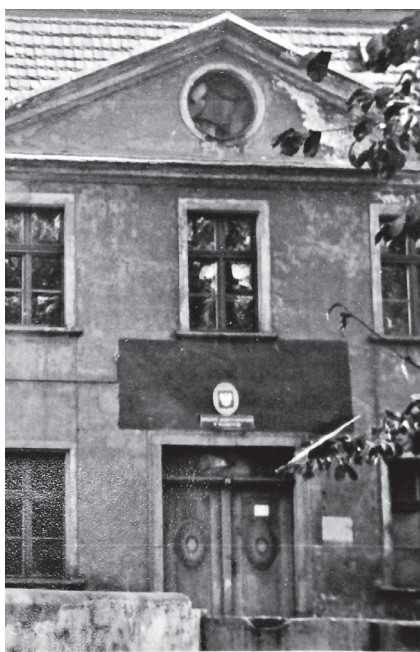
14. Elewacja zachodnia (fragment). Fotografia z 1959 roku. Karta ewidencyjna zabytku architektury i budownictwa. AP Wrocław, Prezydium Wojewódzkiej Rady Narodowej we Wrocławiu, sygn. IX/163. Widoczne podziały stolarki okiennej i okulusa.
