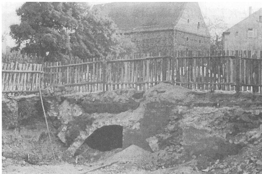
Miasto zapewne odkryje jeszcze niejedną tajemnicę. Na zdjęciu — prace ziemne na jednej z działek budowlanych na Placu Strażackim.
