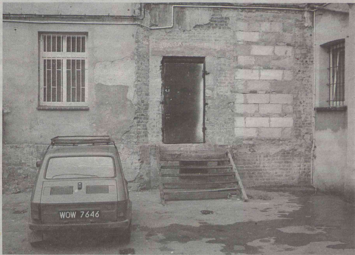
W tym miejscu powstanie posterunek.
