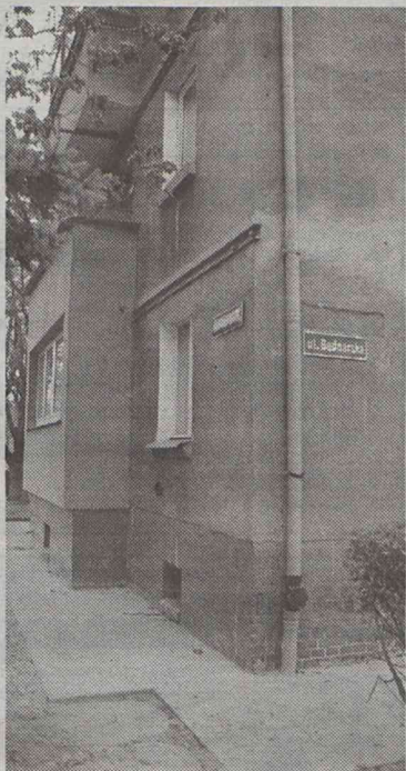
Remontowano na zewnątrz budynku
