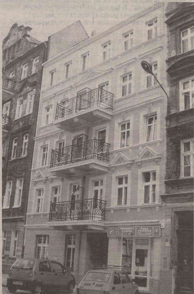
Odnowiony budynek przy ul. Henryka Pobożnego wyróżnia się, wręcz zaskakuje na tle pozostałych kamienic. fot. Adam Winnicki
