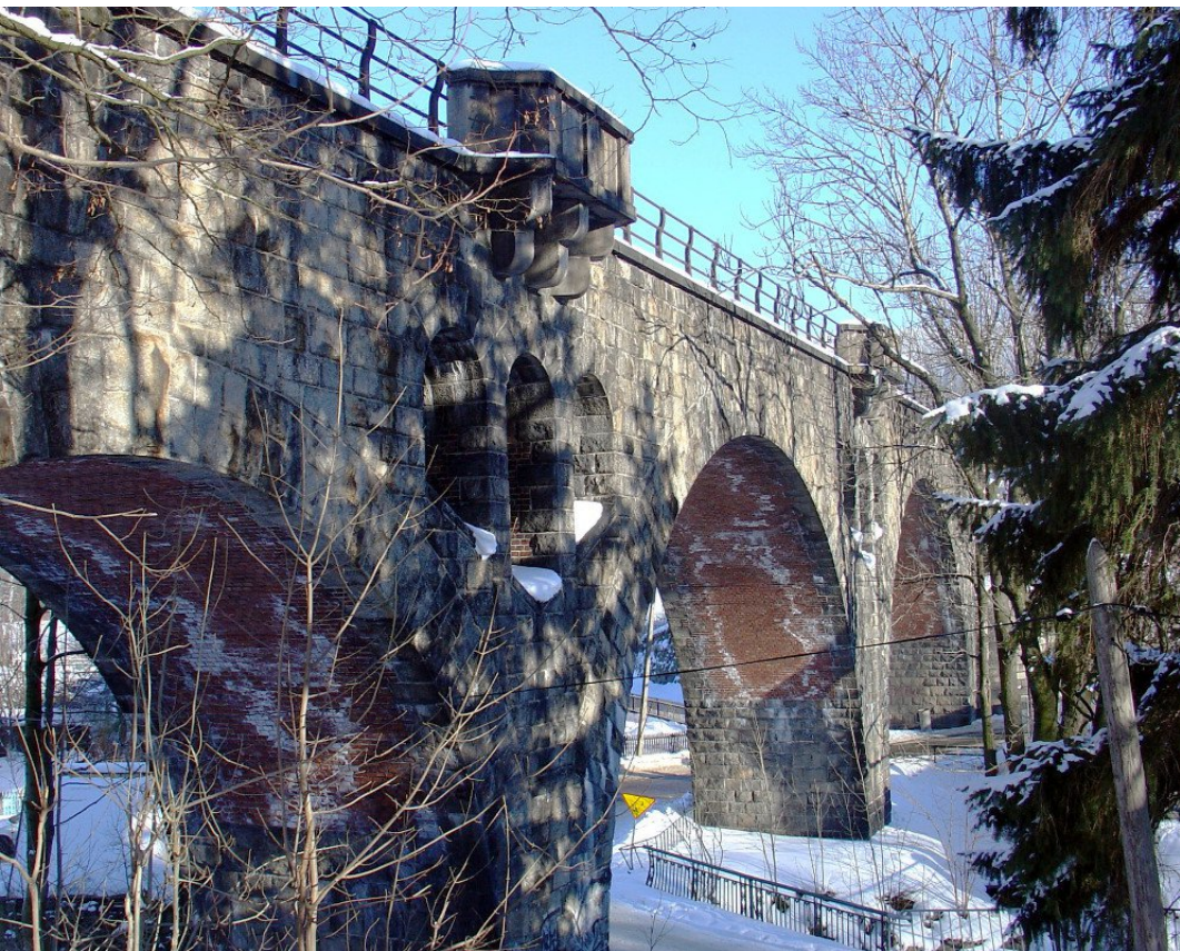
Kamienny most nad potokiem Jedlica i ul. Wiejską w Kowarach
