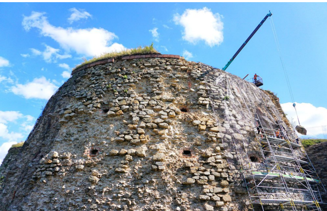
Remont wieży północnej Donjonu / fot. Grzegorz Basiński.
