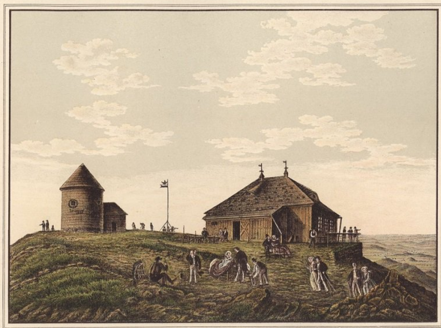
RESTAURATION auf der SCHNEEEKOPPE.
