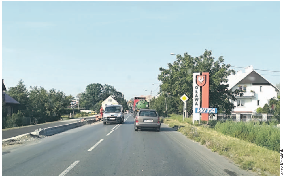
Ścieżki rowerowo piesze już wybudowano. Teraz czas na remont ulicy Oleśnickiej. Utrudnienia będą od 11 sierpnia i potrwać kilka miesięcy
