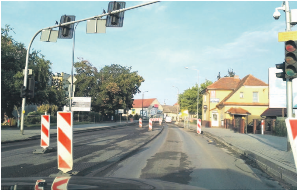
Ta droga była w niezłym stanie, ale na odcinku od ulicy Kutrowskiego do ul. 1 Maja jest wymieniana nawierzchnia
