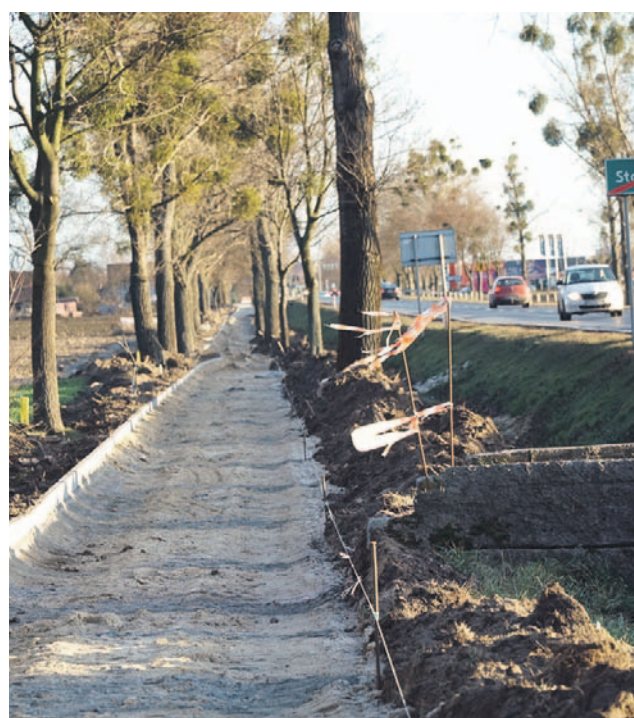
Budowa chodnika trwa
