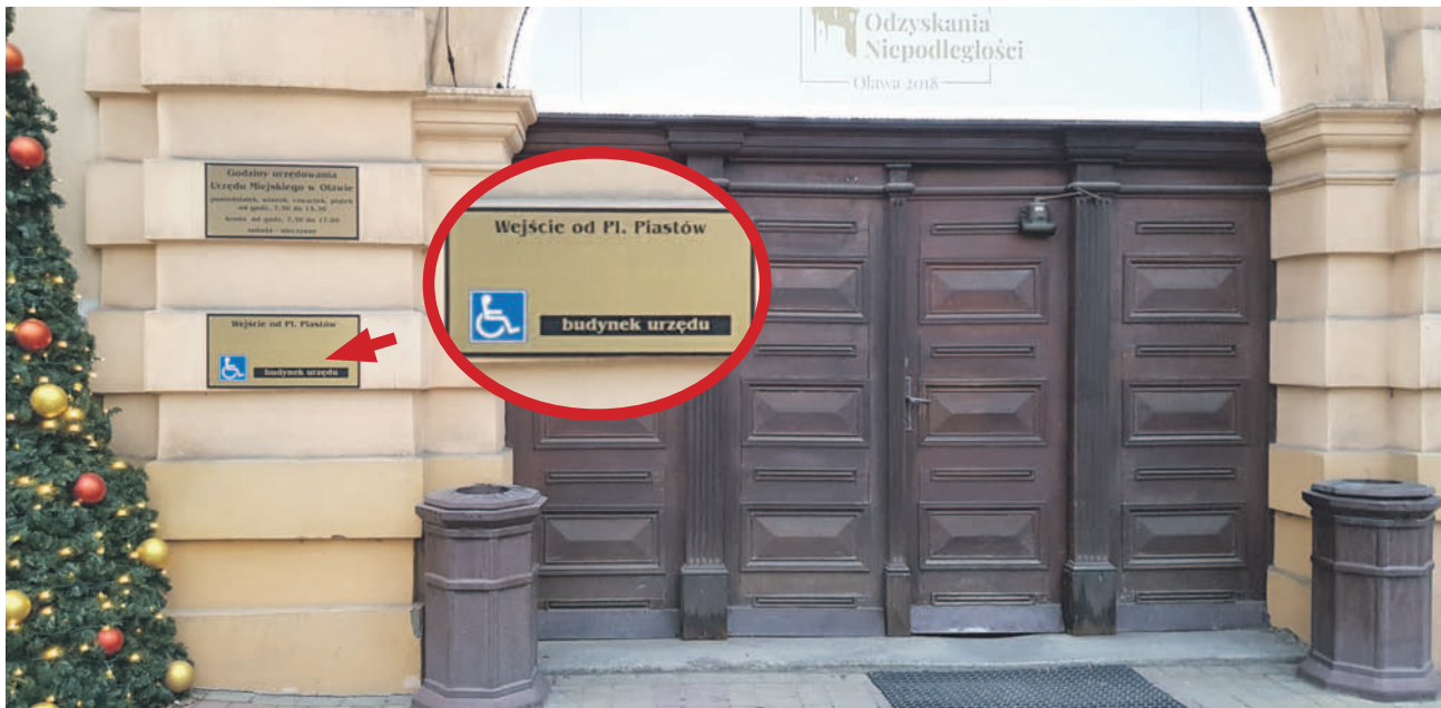
Tabliczka informująca o tym, gdzie jest wejście dla niepełnosprawnych, wisi na budynku Urzędu Miejskiego przy wejściu frontowym. Aby ją przeczytać, trzeba wysiąść z samochodu. Przed budynkiem nie ma jednak parkingu dla inwalidów
