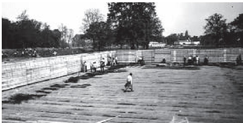
Budowa basenu. Prace przy zbrojeniu wykonywane w czynie społecznym przez pracowników oławskich
