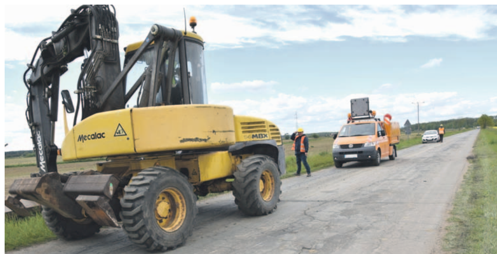
Trwają prace przygotowawcze do przebudowy drogi powiatowej nr 1933D na odcinku „Zakrzów - granica powiatu - Kotowice”. Wartość dofinansowania tego przedsięwzięcia, w ramach Funduszu Dróg Samorządowych, wynosi 600 tys. zł
