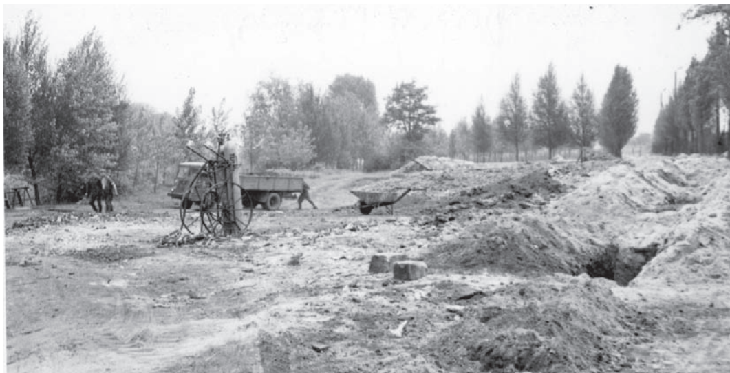
Piaski - prace związane z doprowadzeniem wody i instalacji elektrycznej
