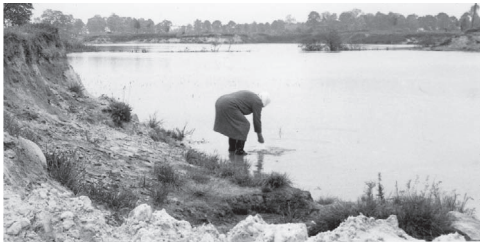
Piaski przed pracami „remontowymi” - w głębi widać most na Odrze przed Ścinawą
