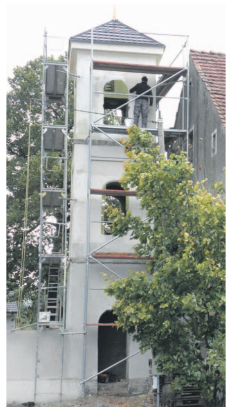
W trakcie remontu - październik 2018
