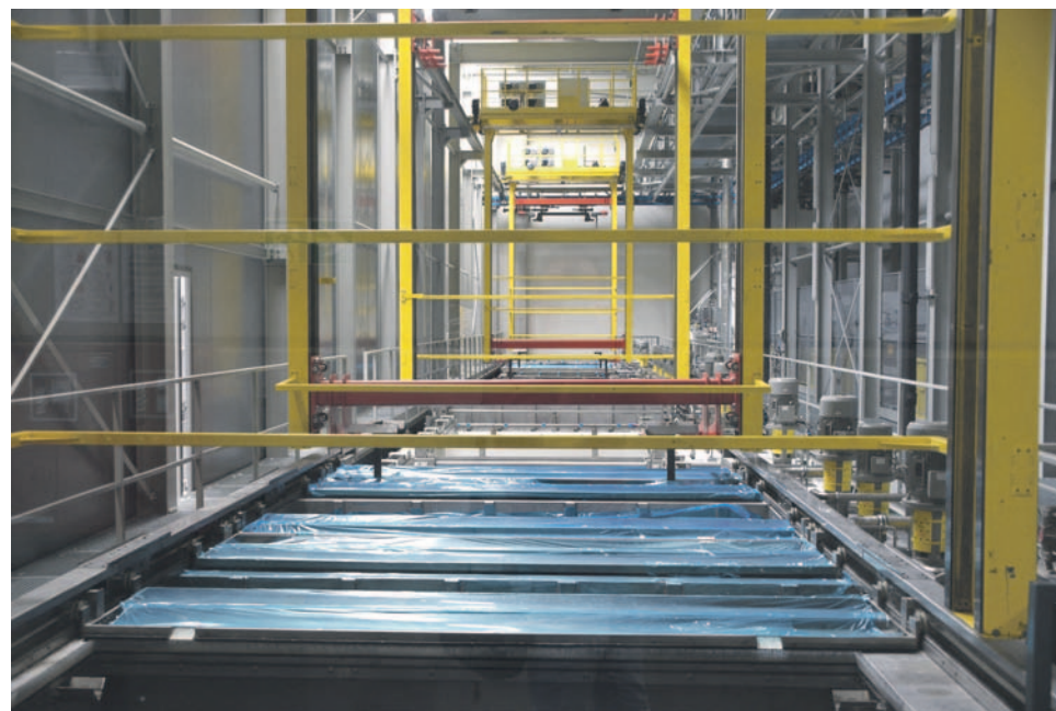
Maszyny są już gotowe do pracy
