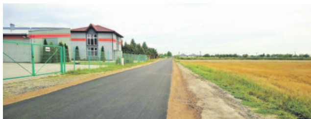
Nowa droga gotowa. Tak wygląda ulica Szmaragdowa
