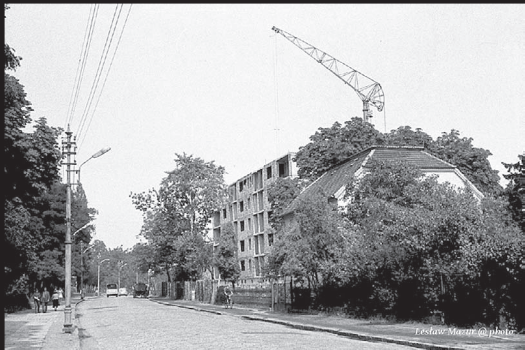
1967. Ulica 1 Maja - budowa bloku
