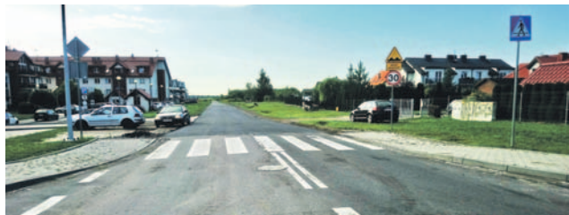
Nowa nawierzchnia na ul. Południowej
