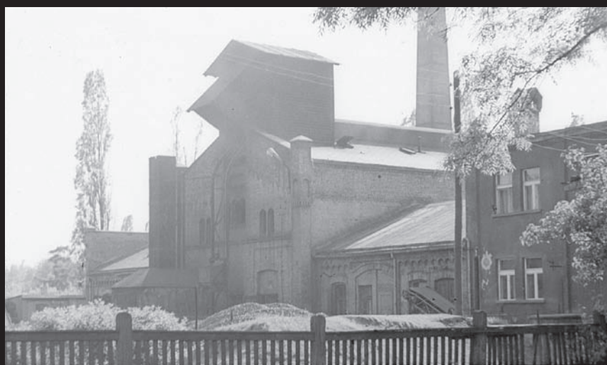
1968. Gazownia miejska - widok od strony miasta
