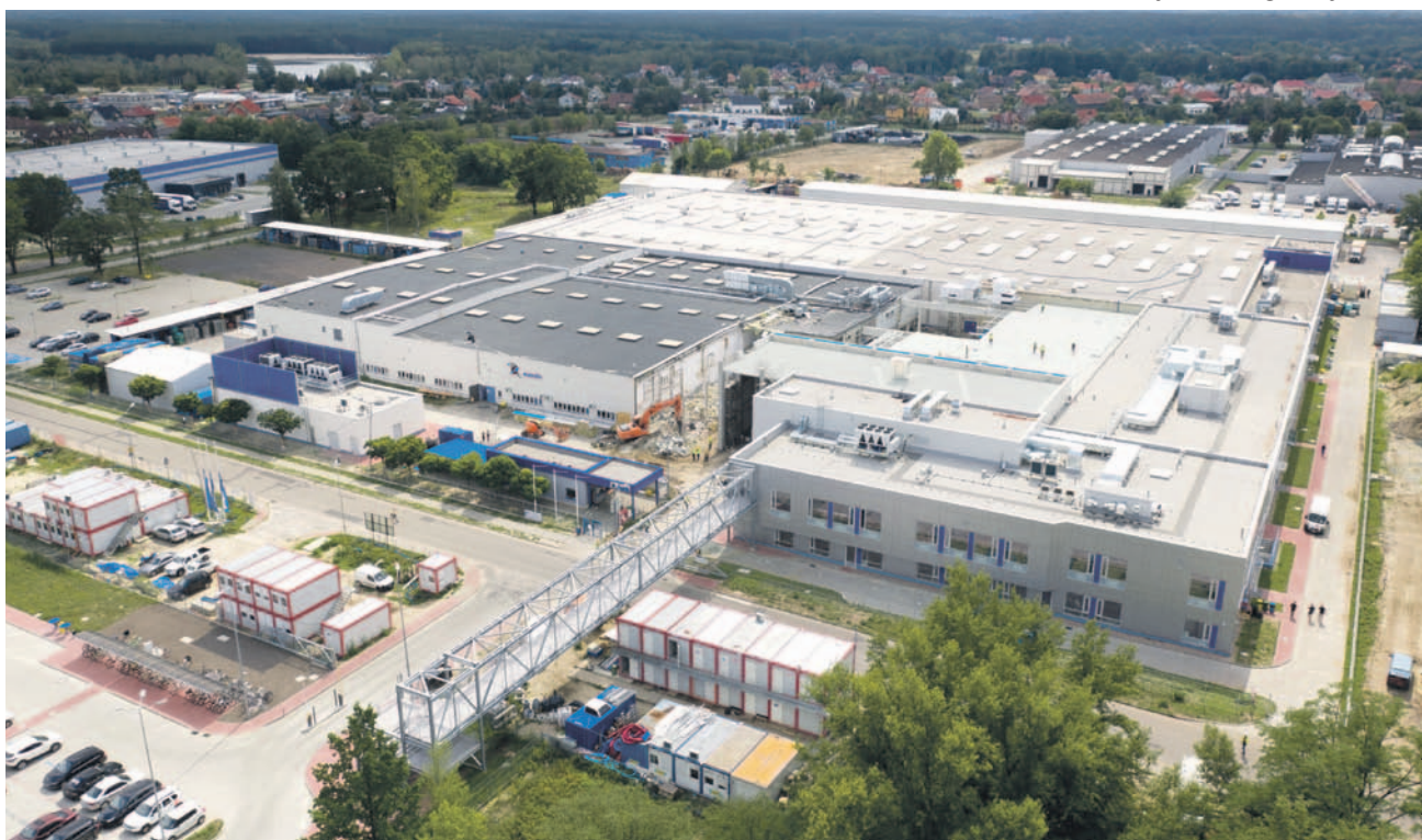
Rozbudowa hali produkcyjnej (APA) pod potrzeby produkcji modułów poduszek powietrznych (airbagów)
