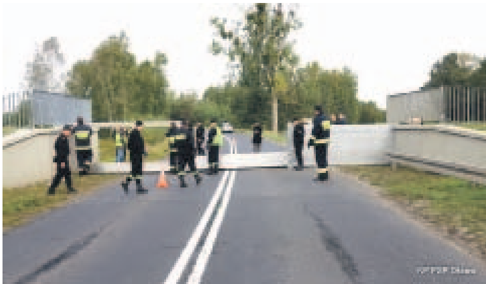
Strażacy montowali specjalną „zapórę”, która w razie powodzi ma powstrzymać wielką wodę
