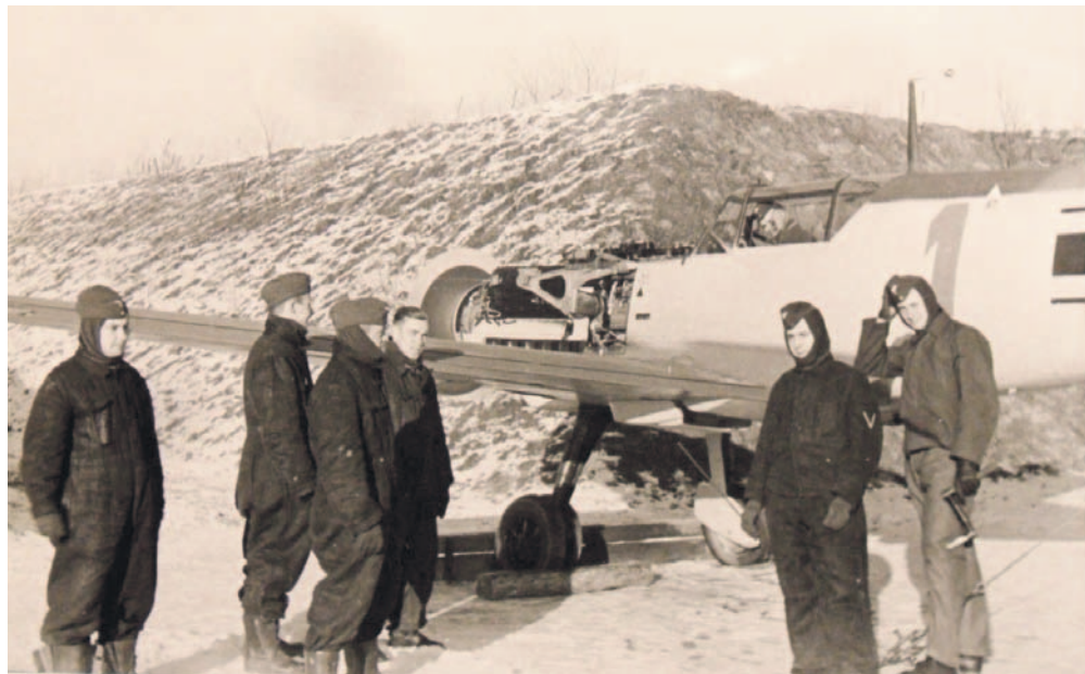
Messerschmitt Bf 109 E na strzelnicy, w mroźnych warunkach. Widzimy solidnie umocowany samolot z pracującym silnikiem, na śmigle założona specjalna tarcza z podziałką służąca do ustawienia synchronizatorów. Mechanik po prawej trzyma w ręku korbę dzięki której, szczególnie w zimie, można było „odpalić” silnik ręcznie, po prostu „na korbę”. Zdjęcie z innej (nie oławskiej) strzelnicy
