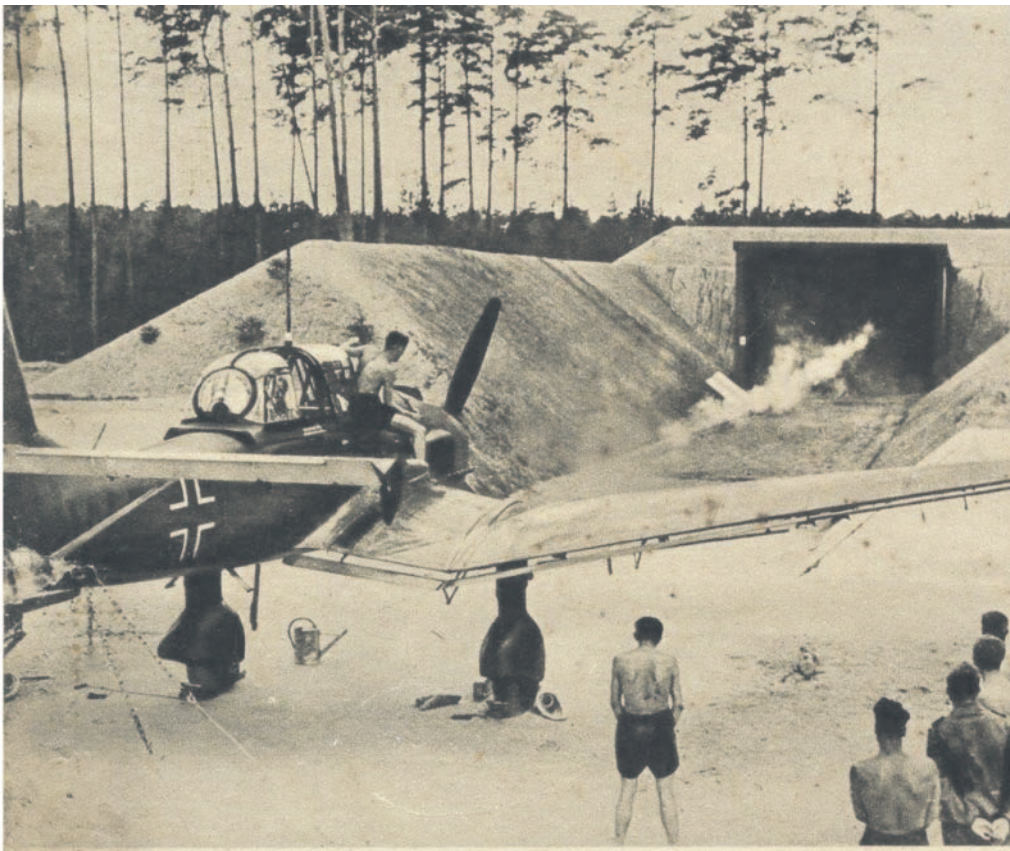
Strzelnice na lotniskach były budowane wg. jednolitego projektu. na zdjęciu strzelnica na innym lotnisku, niemal identyczna z tą w Marcinkowicach, samolot w trakcie strzelania to Junkers Ju 87 Stuka
