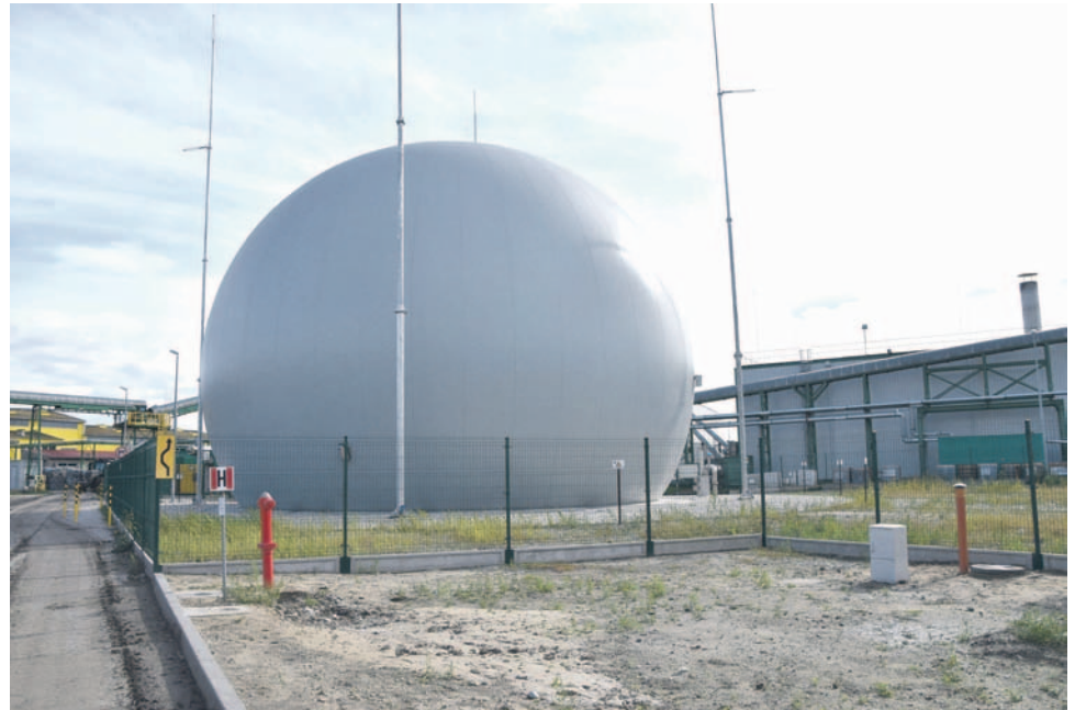
W ramach modernizacji wybudowano m.in. zbiornik na biogaz
