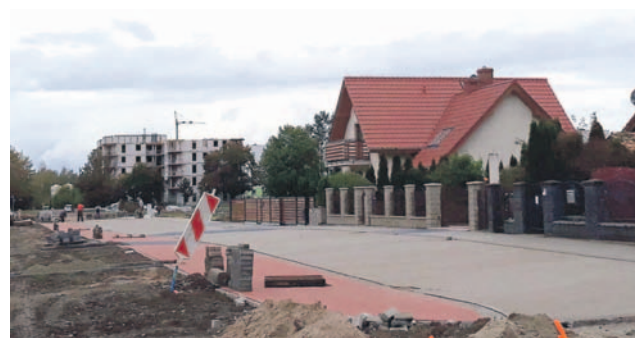
Fragment przebudowanej ul. Bażantowej
