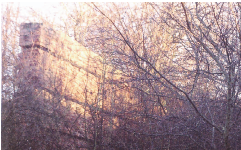
Kulochwyt strzelnicy przed rozbiórką
