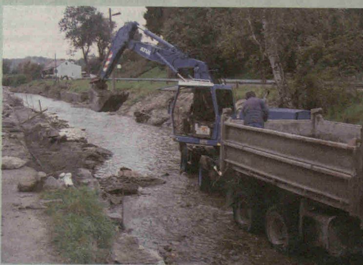
Mury oporowe na Potoku Miłoszowskim są odbudowywane pełną parą. Pogłębiane jest jego koryto.
