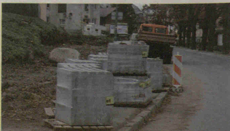
Parking przy ul. Obrońców Pokoju znajduje się przy drodze do „Sandry” i na osiedle Skalne.
