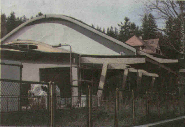
Na tle innych hal tę przy szkole sportowej w Karpaczu wyróżnia owalny dach. Jego elementy konstrukcyjne zbudowane są z klejonego drewna.
