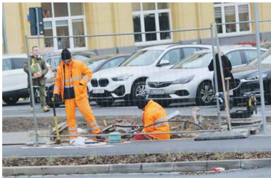
W czasie wykonywania robót drogowych zimą konieczna jest dobra odzież ochronna
