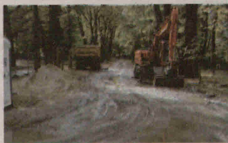
Prace przy renowacji Parku Zdrojowego w Cieplicach
