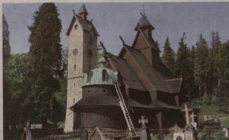
Prace w kaplicy Wang w Karpaczu dofinansowano z RPO WD kwotą 1,2 mln zł.
