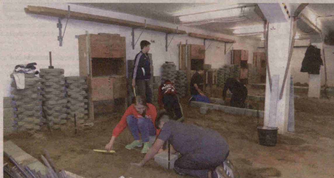
Warsztaty orientacji zawodowej w Saksonii, 24-28.10.2016 (technika budowlana).
