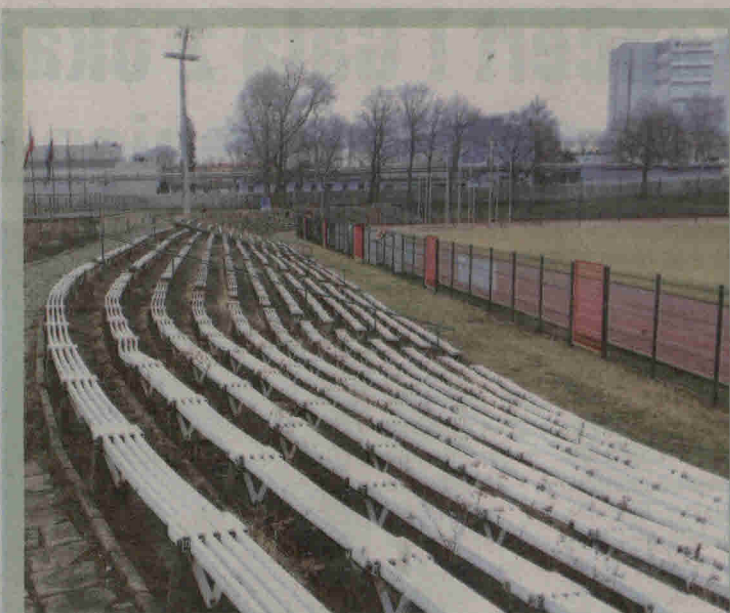
Nie używana od lat trybuna północna zostanie wyburzona, a na jej miejscu powstanie boisko ze sztuczną nawierzchnią.
