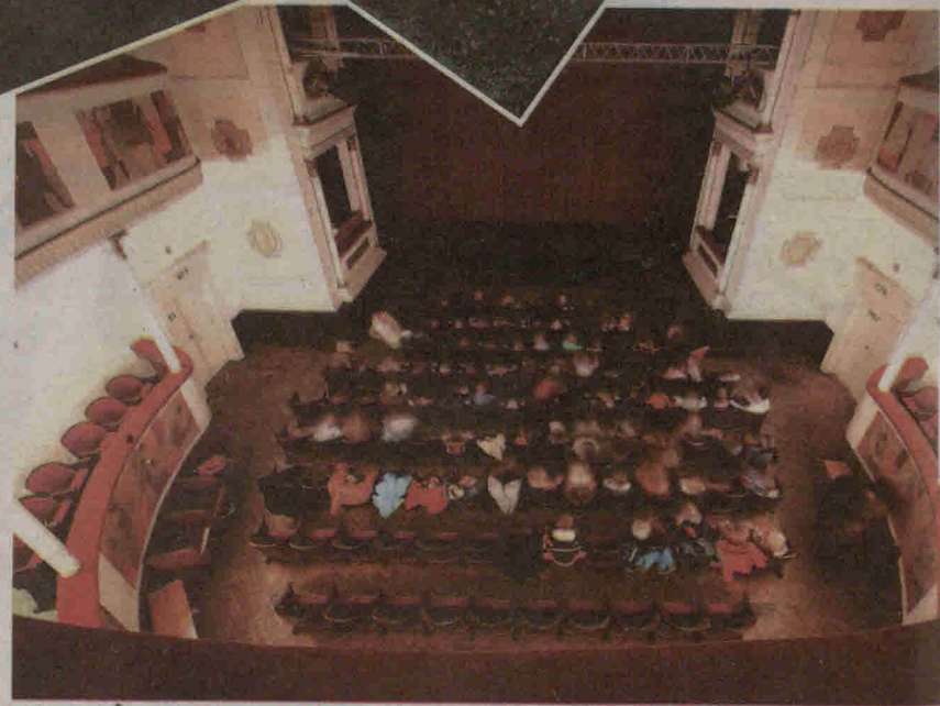
Tak przed kompleksowym remontem wyglądała widownia...
