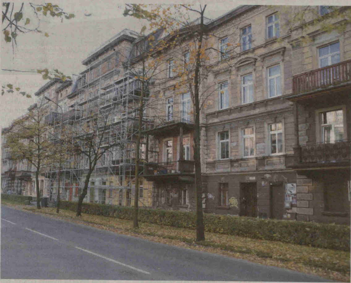
18 zabytkowych kamienic przy al. Wojska Polskiego, dzięki pozyskanym unijnym pieniądzą, zostanie poddanych gruntownemu remontowi. Zaplanowano remonty elewacji, dachów, klatek schodowych, wymianę instalacji elektrycznej i gazowniczej, a także osuszanie budynków.
