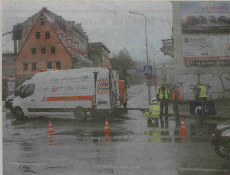
Wiatr zerwał też przyczepy masztu podtrzymującego sygnalizację świetlną na skrzyżowaniu ulic Wojska Polskiego i Sudeckiej.
