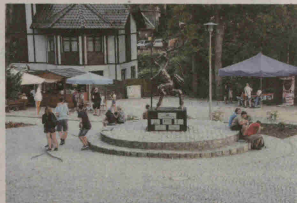
Skwerek Radiowej Trójki. Jedno z reprezentacyjnych miejsc Szklarskiej Poręby, czyli Skwerek Radiowej Trójki zyskał nowe oblicze. W ramach zadania wykonano nawierzchnię z kostki granitowej, dzięki czemu miejskie imprezy będą mogły się odbywać w bardziej komfortowych warunkach.
