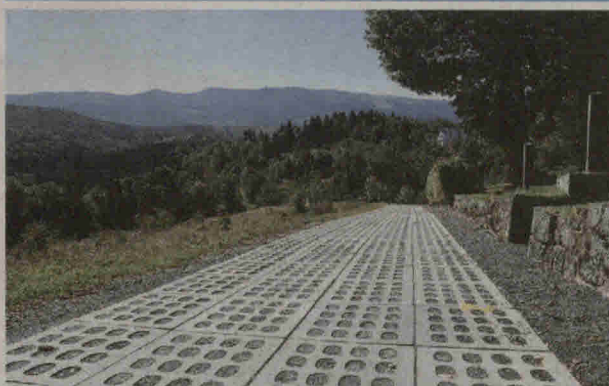
Ulica Wiejska w Szklarskiej Porębie Dolnej zniszczona w czasie ulewnych deszczów w maju 2014 roku. Na długości przeszło 1100 metrów droga została odbudowana, nawierzchnię utwardzono za pomocą płyt typu JOMB.
