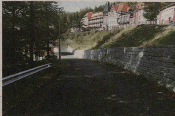
Ulica Sanatoryjna. Przebudowa odcinka ulicy Sanatoryjnej. Roboty obejmowały przebudowę istniejącej drogi gruntowej na drogę publiczną (gminną), o nowej nawierzchni.
