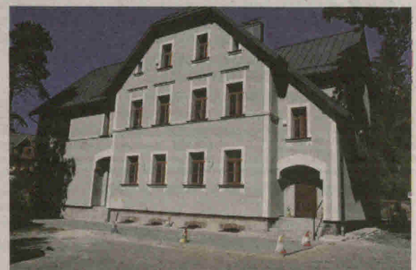
MOKSIAL Budynek Miejskiego Ośrodka Kultury, Sportu i Aktywności Lokalnej przez wiele lat straszyl wyglądem. Teraz doczekał się gruntownego remontu. Wymiana dachu, termomodernizacja budynku, wymiana instalacji elektrycznej konieczna była nie tylko ze względów estetycznych, ale przede wszystkim dla bezpieczeństwa.
