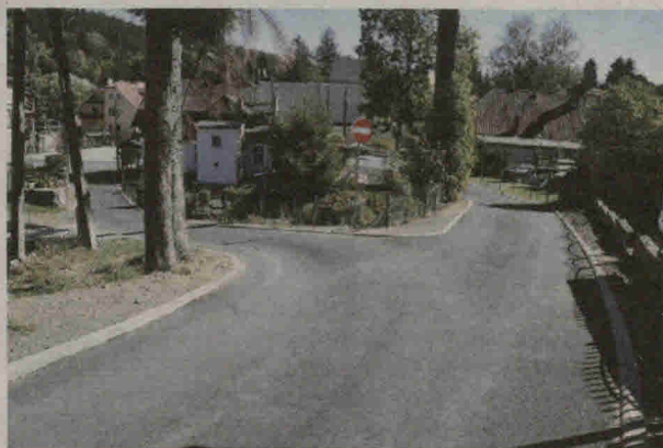
Ulica Demokratów. Przebudowane zostały odcinki o łącznej długości ok. 380 mb.
