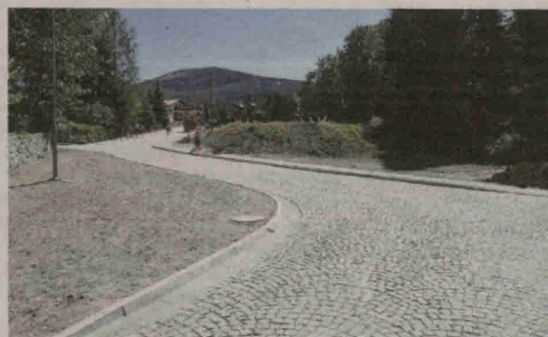
Ulica Turystyczna. Gruntowna przebudowa tej ulicy, łączącej centrum miasta z wyciągiem na Szrenicę, to niewątpliwie najpoważniejsza inwestycja w infrastrukturę drogową w mieście na przestrzeni ostatnich lat. Ulica ma nową podbudowę z nawierzchnią z kostki brukowej i nowe oświetlenie.
