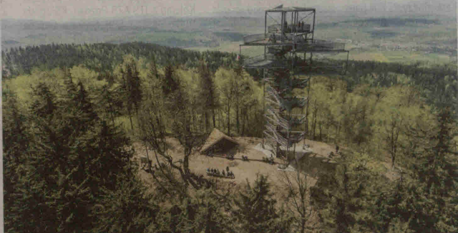
Wieża składa się z platform widokowych na pięciu kondygnacjach.
