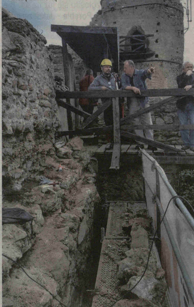
Widok na mur wschodni (po lewej), pomost i wieżę zamkową
